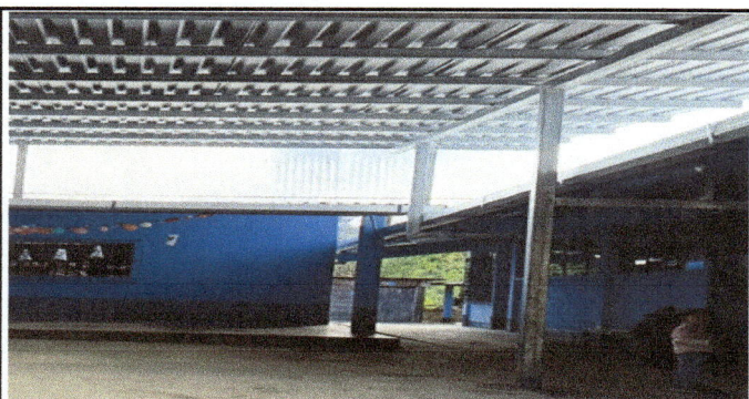
Foto 5: Modulo 2 (corredor) columna de metal sustituida e instalada, anteriormente se tenian columnas de madera.
