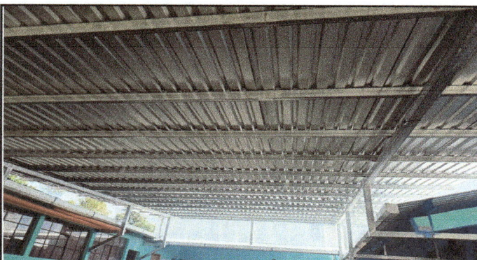
Foto 3: Modulo 2 (corredor) estructura de metal instalada.
