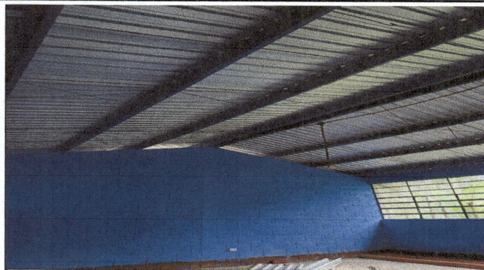
Foto 2: modulo 1. mantenimiento de estructura de metal (lijado, cepillado, limpieza, aplicación de anticorrosivo mas pintura de esmalte.
