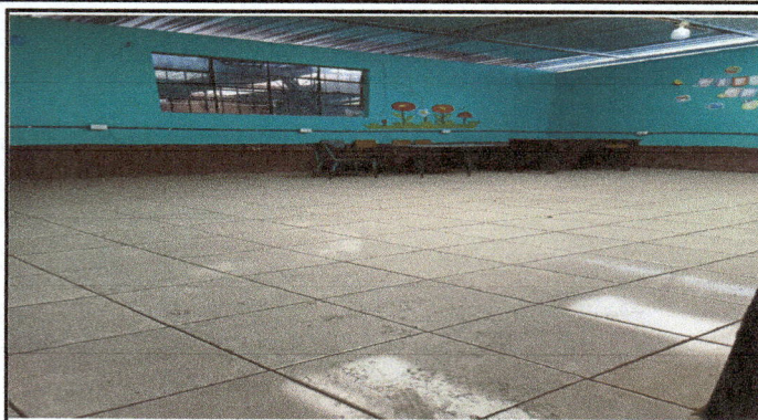
Foto 8: Módulo 2. piso cerámico nuevo instalado en aula 6 de computacion.
