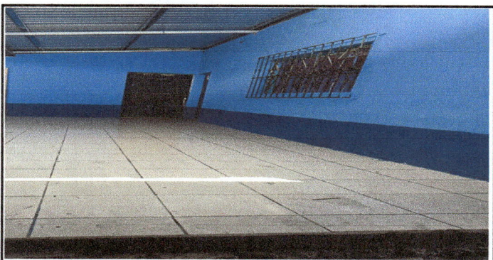
Foto 11: piso cerámico instalado en corredor en frente del aula 6 del módulo 2
