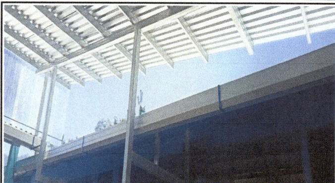
Foto1: Modulo 1. Cubierta de láminas y colocacion de canales.
