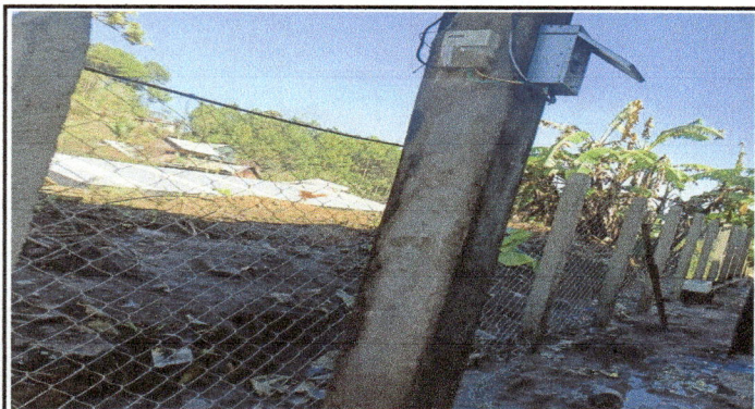
Foto 9: muro perimetral al lado izquierdo del porton rehabilitado. (malla sustituida)
