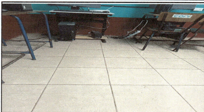
Foto 7: Módulo 2. piso cerámico nuevo instalado en aula 6 de computacion.
