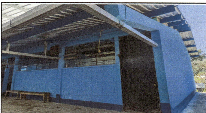
Foto 10: paredes exteriores con pintura nueva aplicada.
