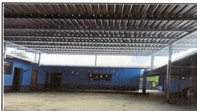
Foto 4: Modulo 1 (dirección) piso cerámico instalado. Y pintura nueva aplicada en paredes exteriores
